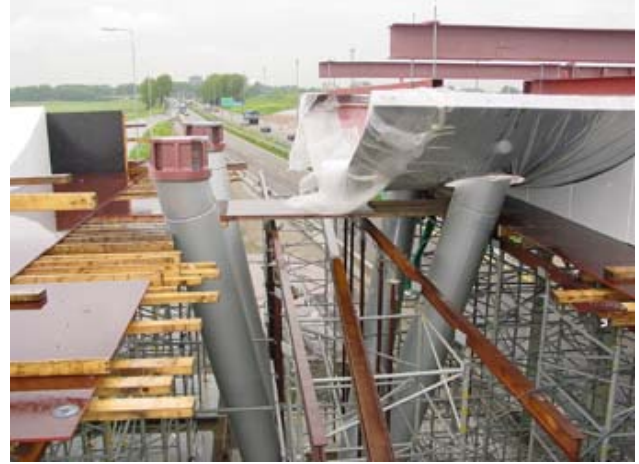
figuur 15 Het viaduct in aanbouw
