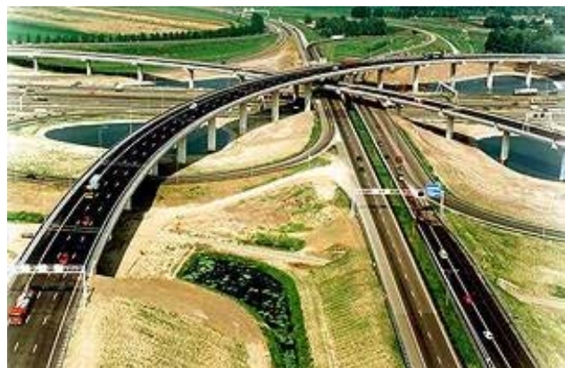
figuur 12 Overzichtsfoto van viaduct Vaanplein/Ridderkerk
